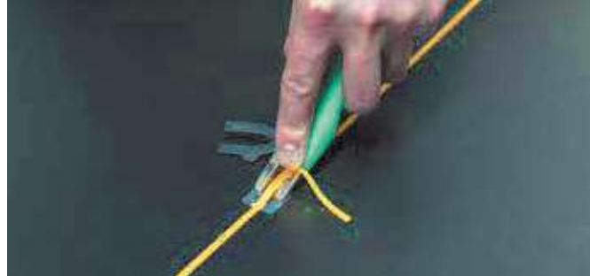
Repaso sencillo de las costuras de soldadura con la cuchilla de raspado de Leister.
